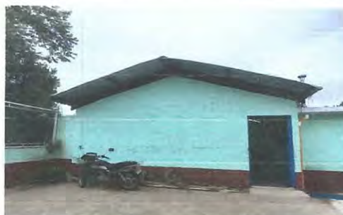
Foto 2: MEJORAMIENTO DE TECHO DE AULA CON LAMINA TROQUELADA Y SOPORTE DE METAL
