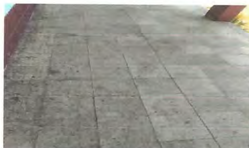
Foto 4: SUSTITUCIÓN DE PISO PARA MODULO ESCOLAR
