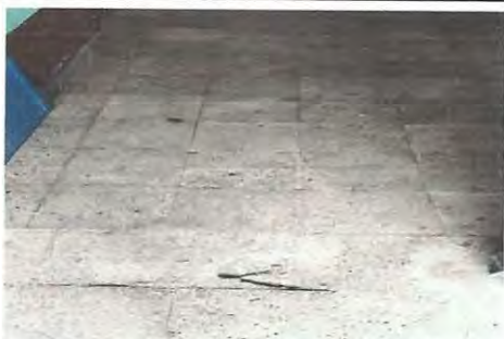
Foto 3: SUSTITUCIÓN DE PISO PARA MODULO ESCOLAR
